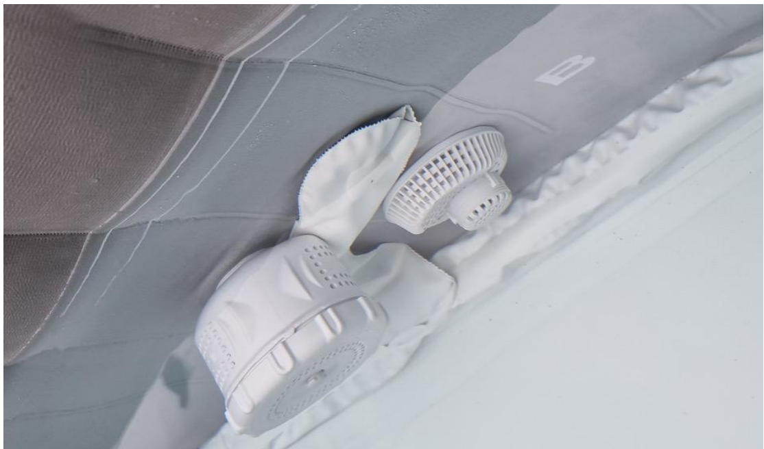
Filterkartuschenbehälter falsch montiert:
